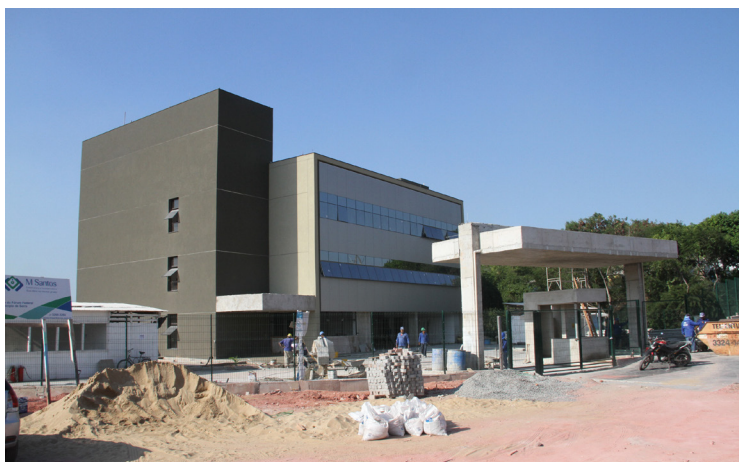
Obra da nova sede, em fase final de acabamento
