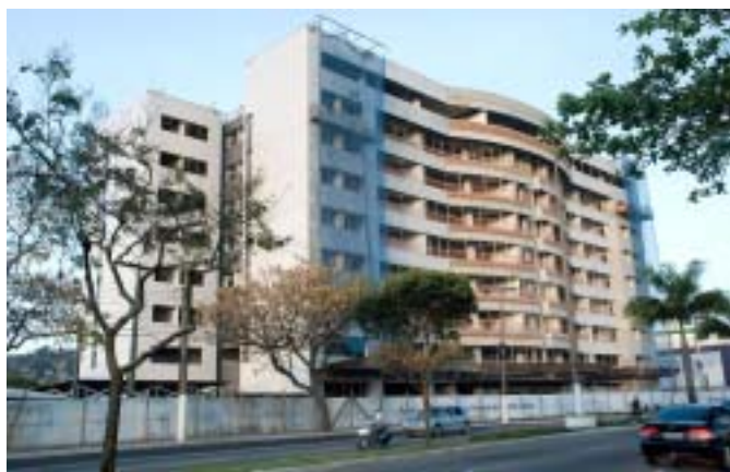
Obra da futura sede da Justiça Federal (Av. Marechal Mascarenhas de Moraes, 1877, Ilha de Monte Belo, Vitória)
